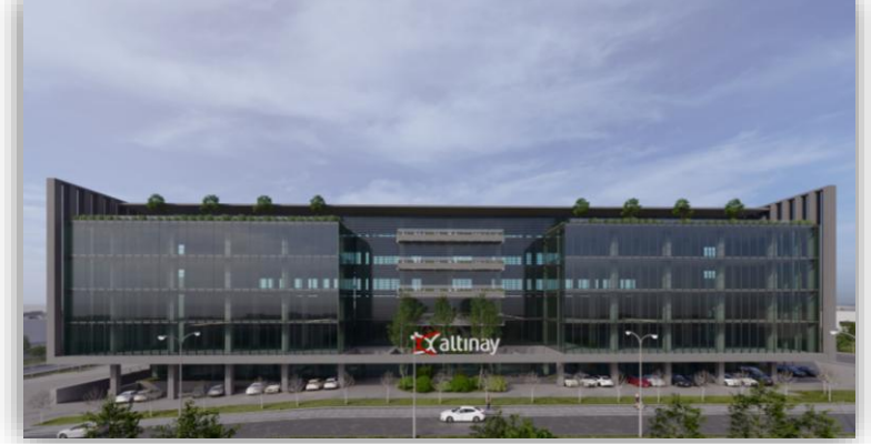
TEKNOLOJİ KAMPÜSÜ TUZLA DERİ OSB/ İSTANBUL (Yapım Aşamasında)
